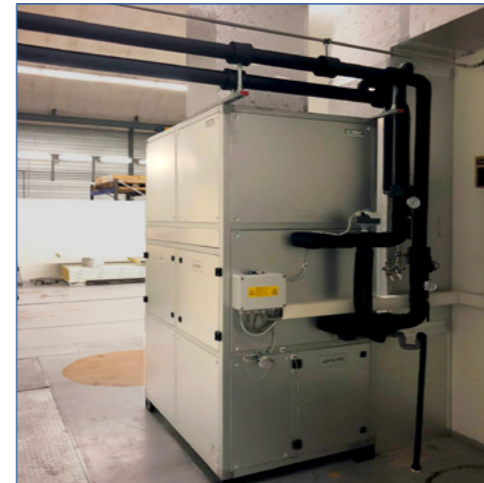
Macchine monoblocco IDROBLOKK e U.T.A. ad elevata precisione
