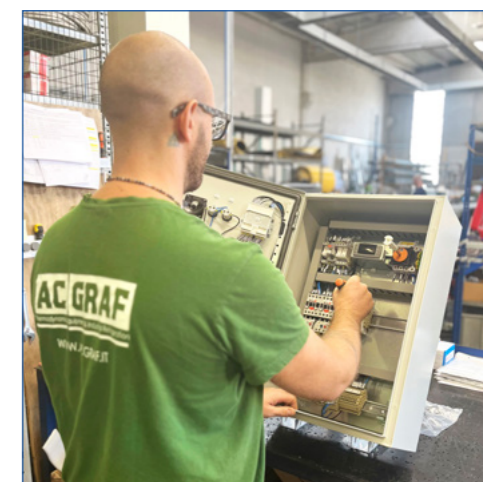
Cablaggio dei quadri elettrici
