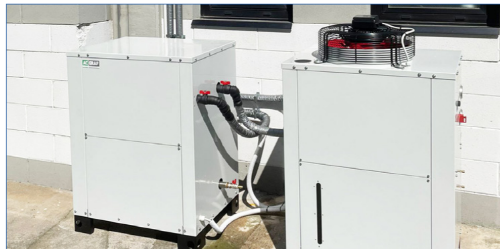
Refrigeratore di liquido «aria-acqua» o «acqua-acqua» con serbatoio e pompa
