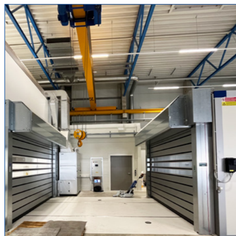
Portoni a rullo coibentato per la movimentazione dalla camera di acclimatazione alla sala collaudo
